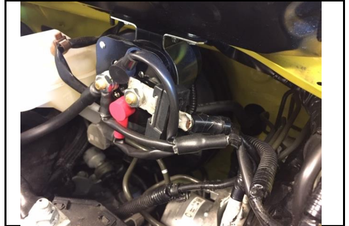
B2-2) Megszakító Safety breaker
